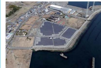
Фотоэлектрическая установка мощностью 2 МВтф для солнечной электростанции на о. Авадзи, Япония
