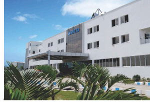
Завод в г. Рудрапур
