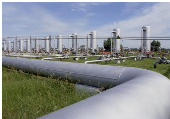
Низкое давление, большой поток
